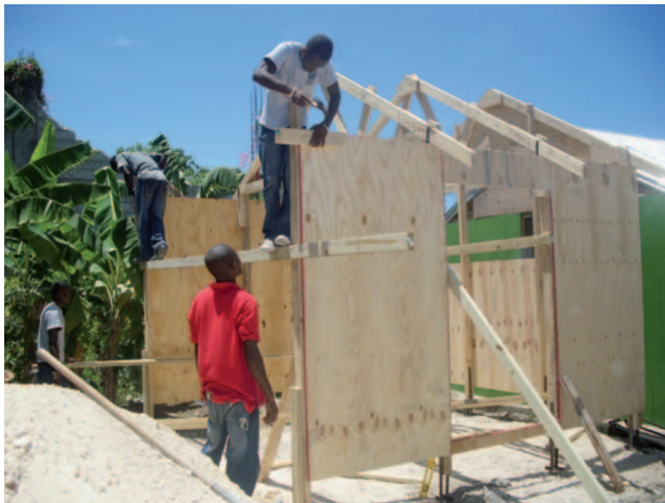
Construction d'un abri transitoire par ADRA qui a reçu des conseils du CCR. Source : R. Zemp
