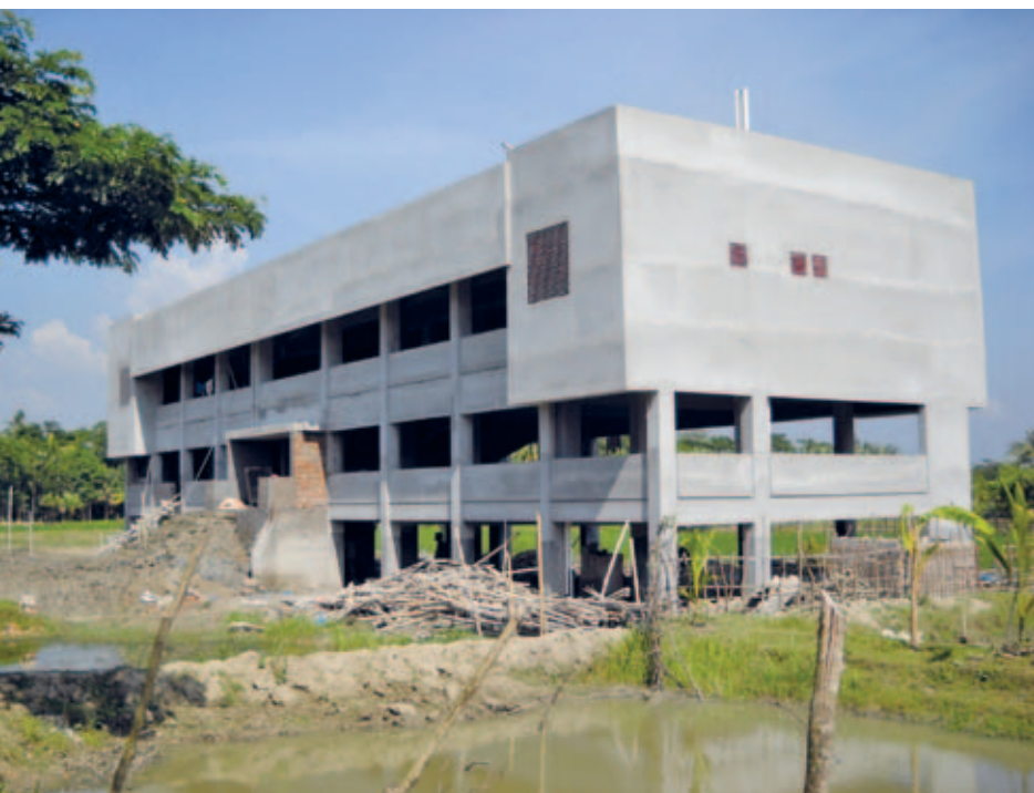
Un abri anticyclone en construction à Hogolpati, Bangladesh. Source : F. Poffet
