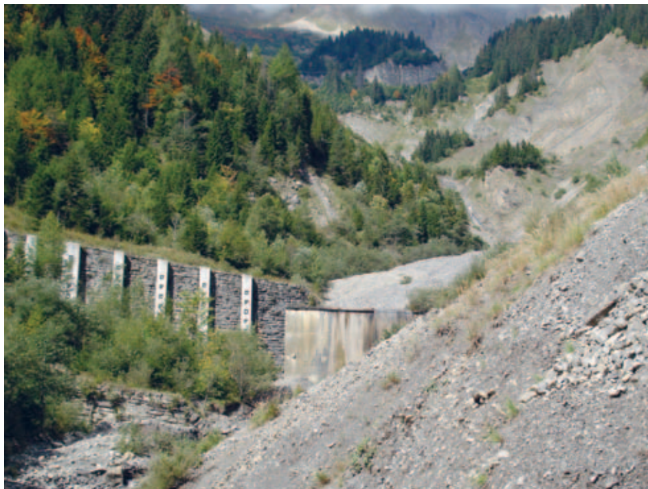
Les barrages du Lammbach (commune de Schwanden) et le boisement des versants ont permis de réduire le risque de laves torrentielles. Source : M. Zimmermann
